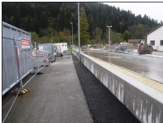
Bild: Zustand nach Bau der Maßnahme
